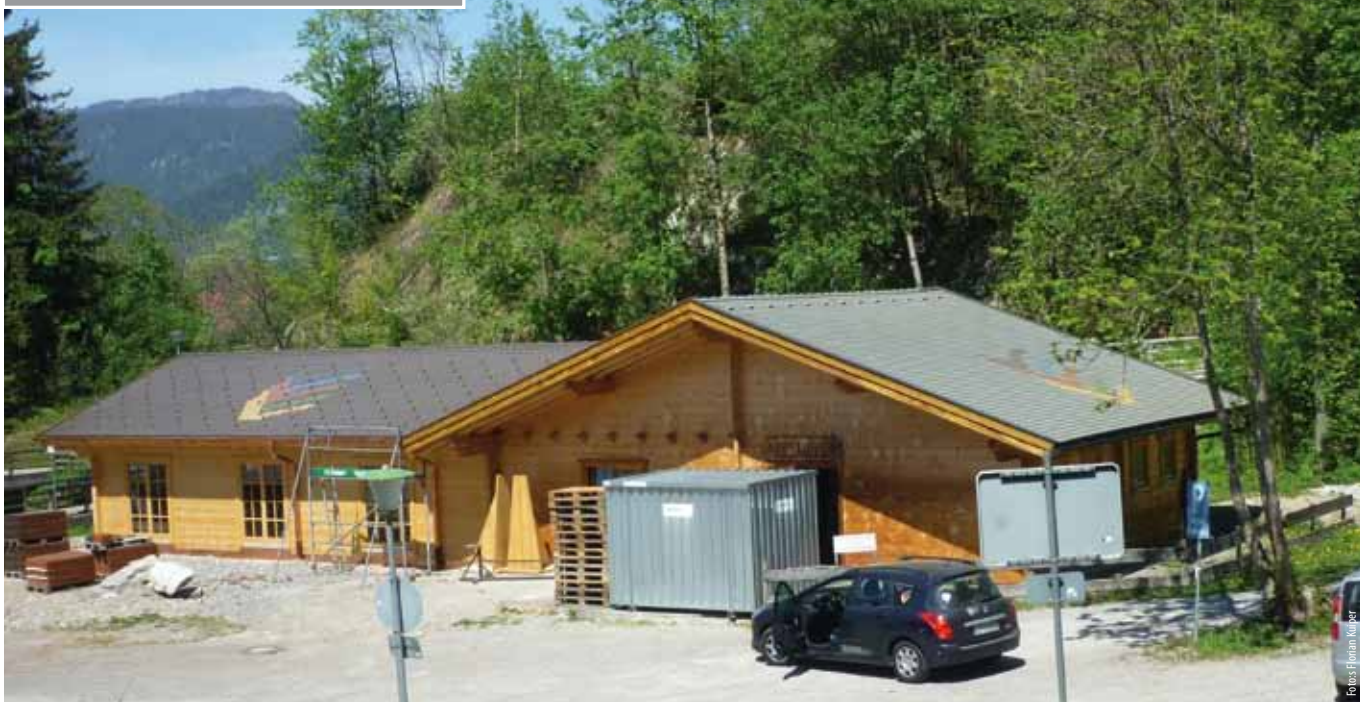
Die KraftAlp mit neuem Anbau ist seit Anfang Mai wieder in Betrieb und bietet nun mehr Platz für das Krafttraining.
